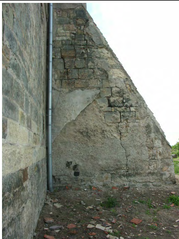
Opěrák severovýchodního nároží lodi v pohledu od východu. Foto: Jan Koloc, 2004.
