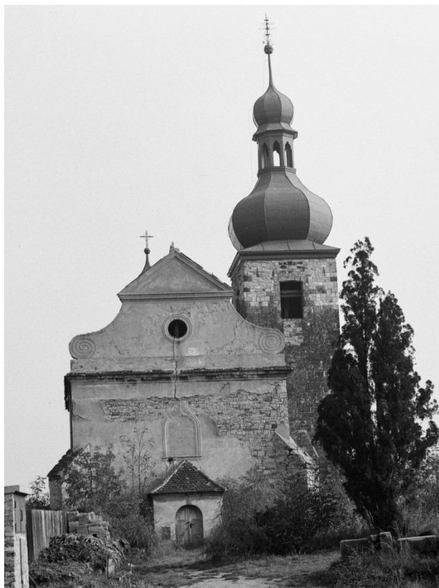
Celkový pohled od západu. Foto: 1987, sbírka negativů NPÚ ÚOP v Ústí n. L., sign. 95479.
