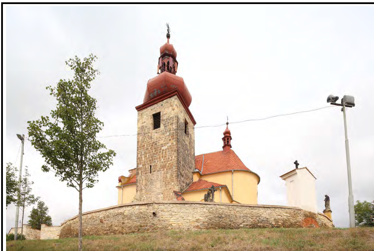
Celkový pohled od jihovýchodu. Foto: Marta Pavlíková, 2018.
