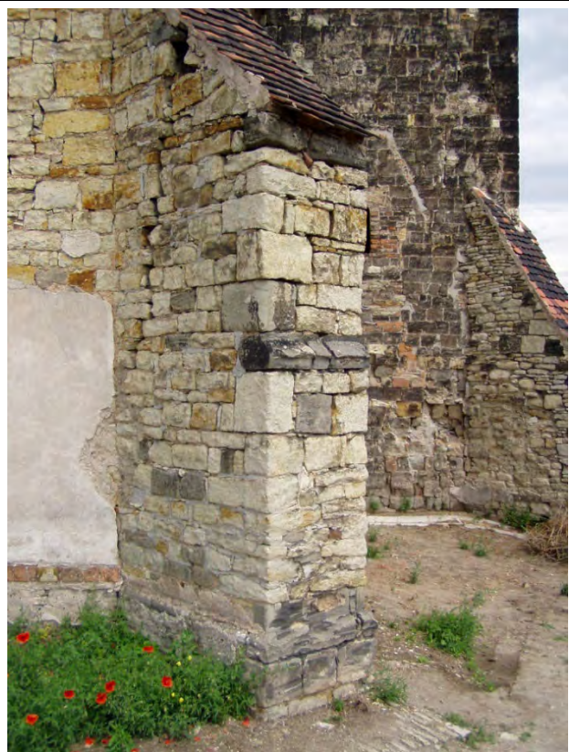
Jihozápadní opěrák lodi v pohledu od západu. Foto: Jan Koloc, 2004.
