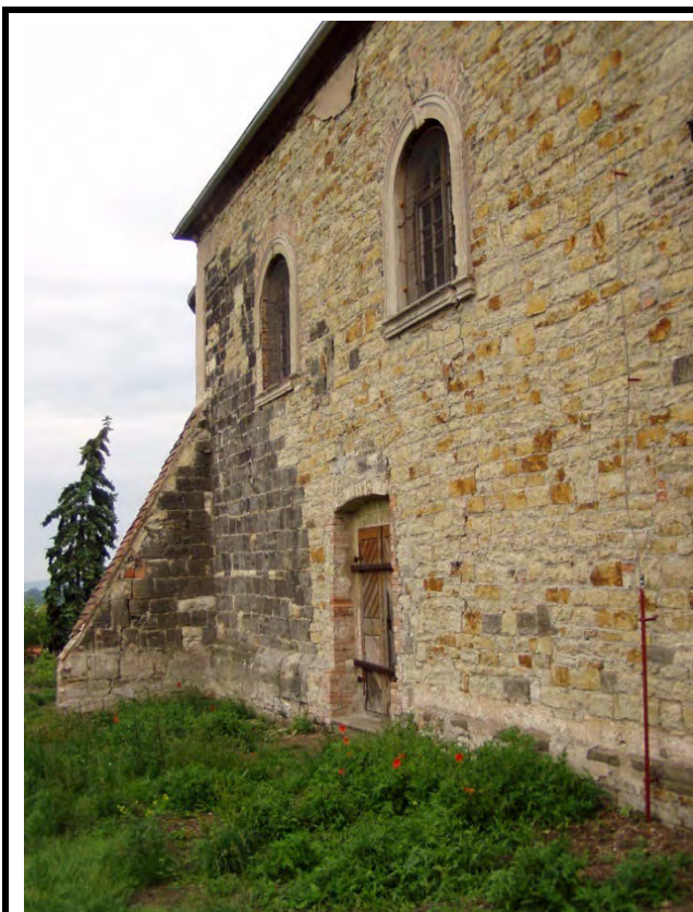
Severní průčelí lodi v pohledu od severozápadu. Foto: Jan Koloc, 2004.
