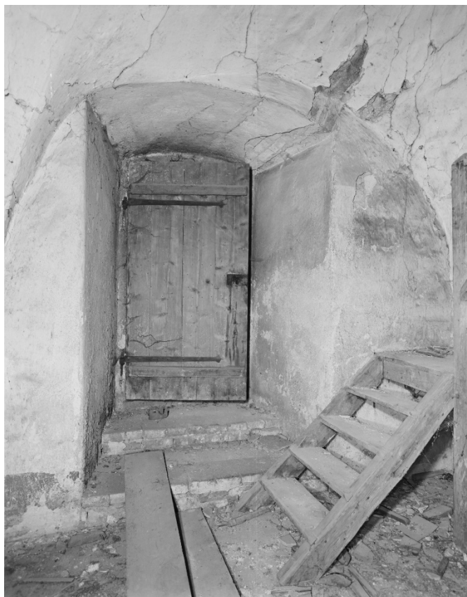
Západní strana přízemí věže. Foto: 2001, sbírka negativů NPÚ ÚOP v Ústí n. L., sign. 143138.
