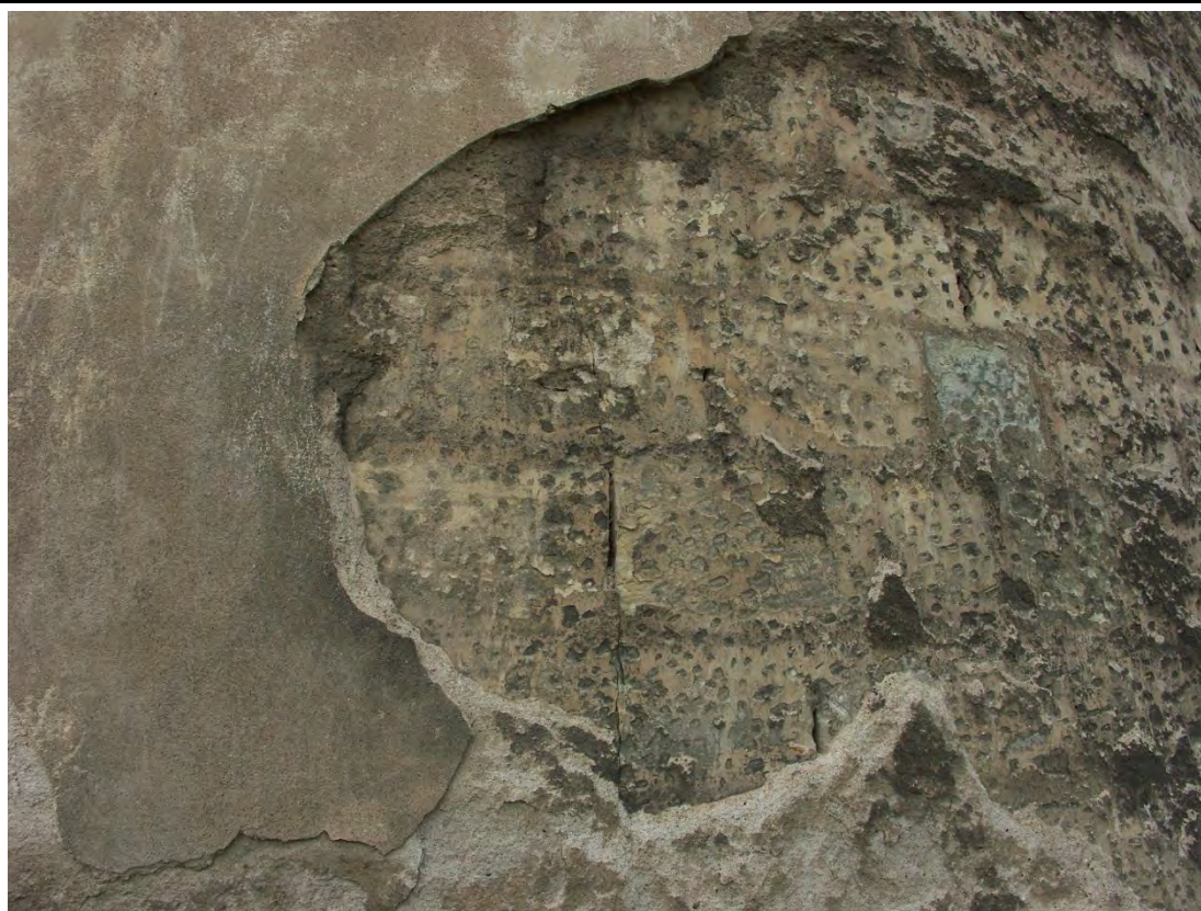
Detail odhaleného líce zdiva východního průčelí presbytáře. Foto: Jan Koloc, 2004.
