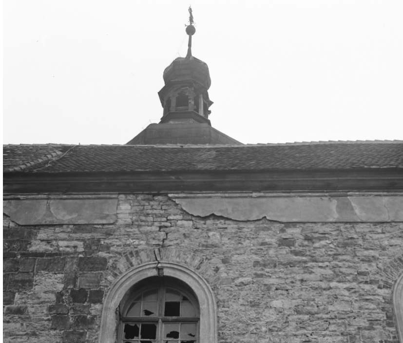
Horní partie severního průčelí lodi. Foto: 1979, sbírka negativů NPÚ ÚOP v Ústí n. L., sign. 61261.
