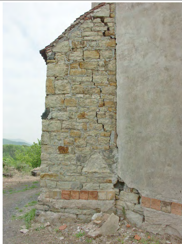
Severozápadní opěrák lodi v pohledu od jihozápadu. Foto: Jan Koloc, 2004.
