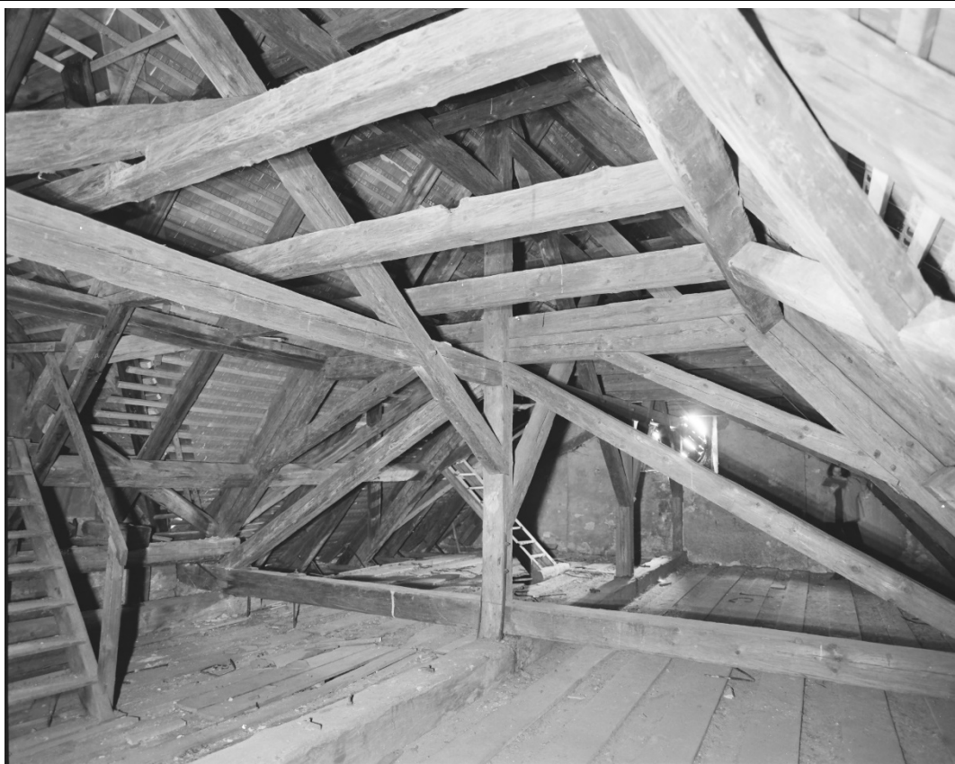
Krov nad lodí v pohledu od východu. Foto: 2001, sbírka negativů NPÚ ÚOP v Ústí n. L., sign. 143145.
