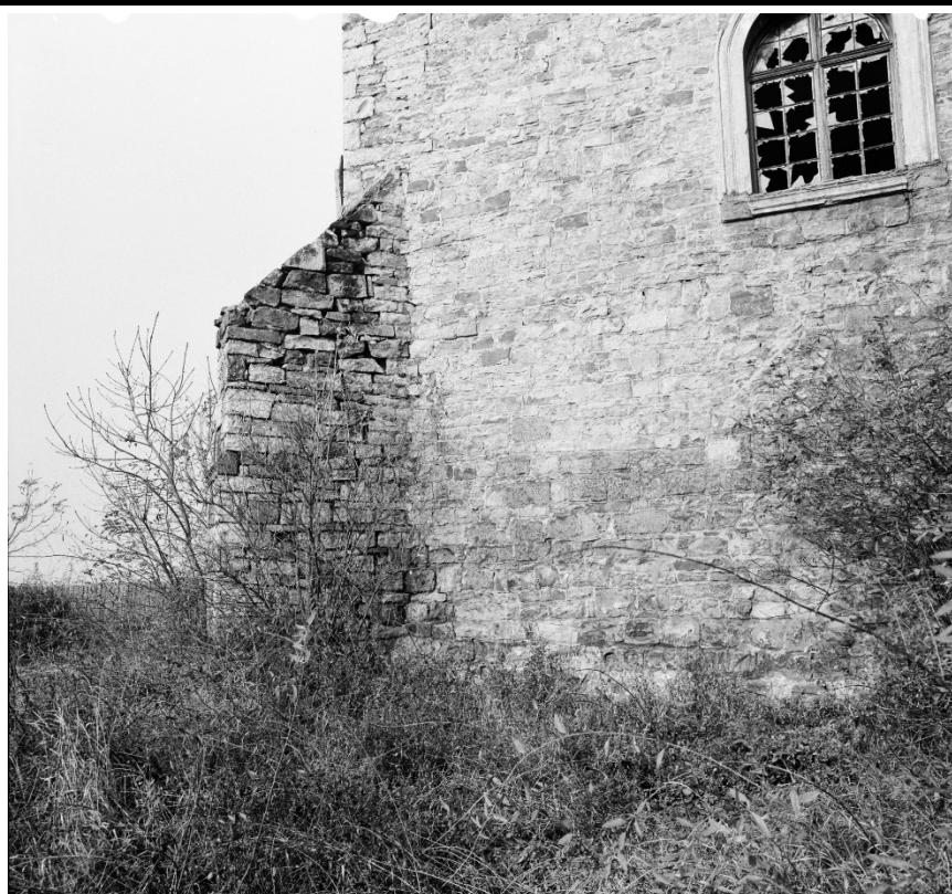
Západní konec jižního průčelí lodi s jhozápadním opěrákem. Foto: 1987, sbírka negativů NPÚ ÚOP v Ústí n. L., sign. 95483.
