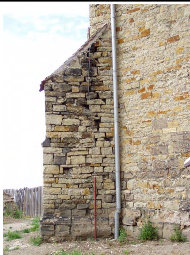
Jihozápadní opěrák lodi v pohledu od jihovýchodu. Foto: Jan Koloc, 2004.
