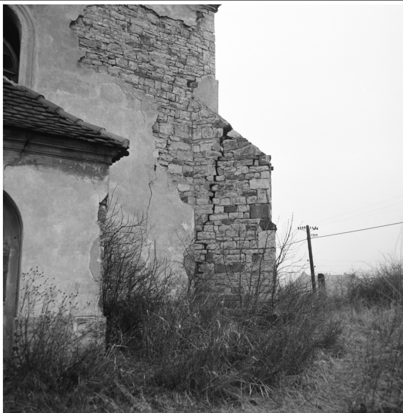
Jihozápadní opěrák lodi v pohledu od severozápadu. Foto: 1979, sbírka negativů NPÚ ÚOP v Ústí n. L., sign. 61257.
