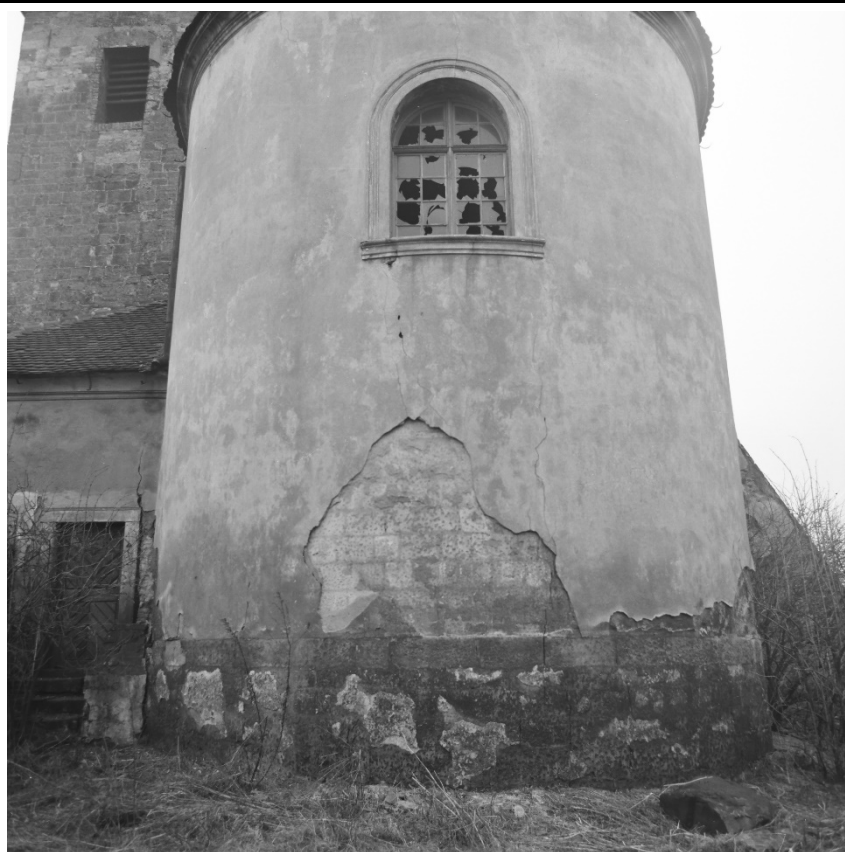
Východní průčelí presbytáře. Foto: 1979, sbírka negativů NPÚ ÚOP v Ústí n. L., sign. 61260.
