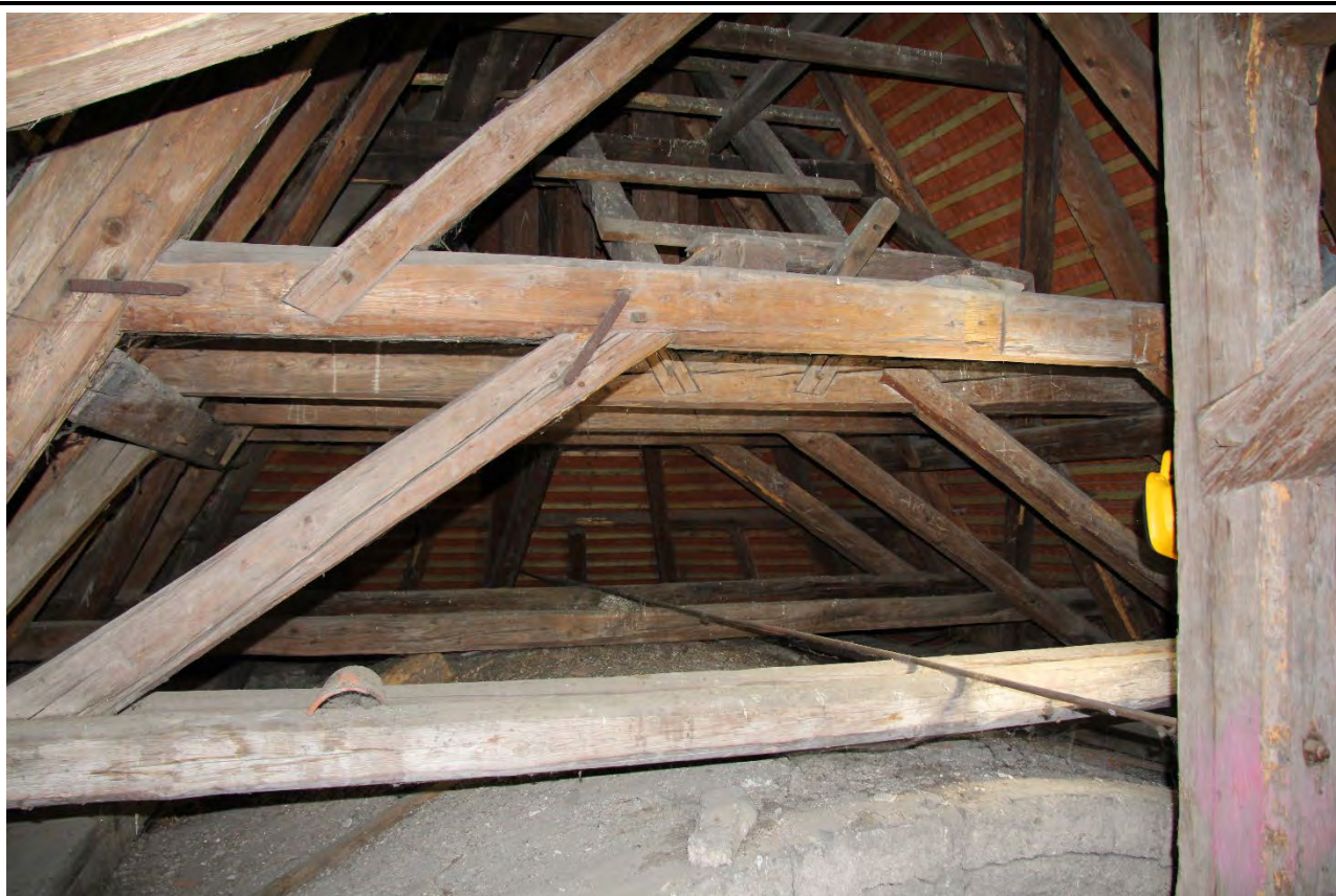
Krov nad presbytářem v pohledu od západu. Foto: Jaroslav Skopec, 2018.
