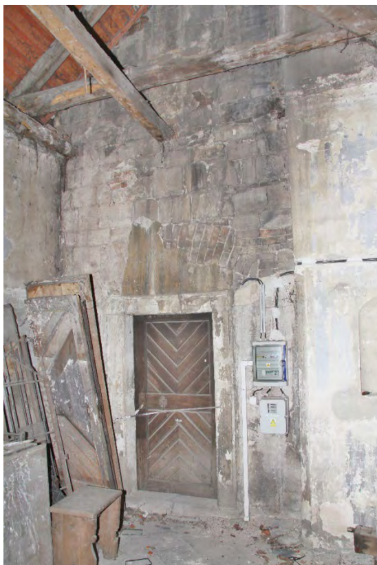
Spodní partie východní exteriérové strany přízemí věže v pohledu od východu z prostoru bývalé sakristie. Foto: Jaroslav Skopec, 2019.
