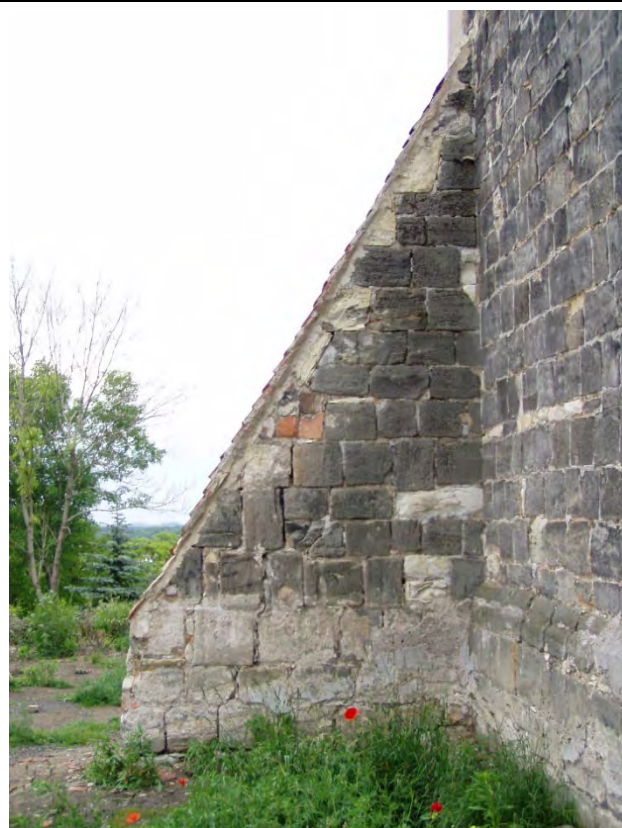
Opěrák severovýchodního nároží lodi v pohledu od západu. Foto: Jan Koloc, 2004.
