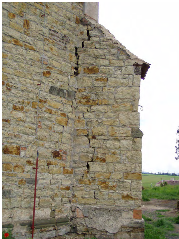
Severozápadní opěrák lodi v pohledu od severovýchodu. Foto: Jan Koloc, 2004.
