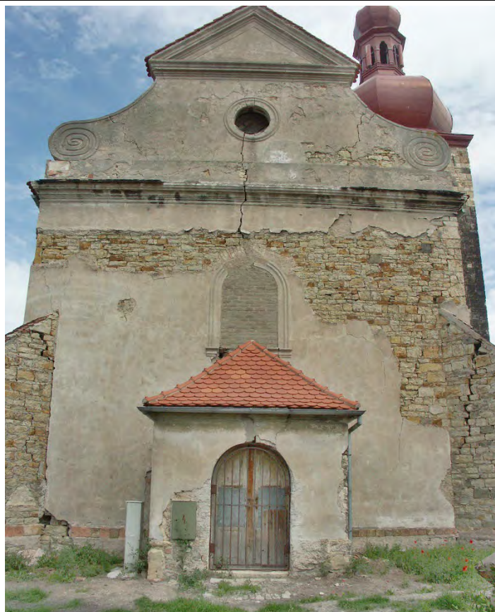
Západní průčelí lodi s odhaleným lícem zdiva. Foto: Jan Koloc, 2004.
