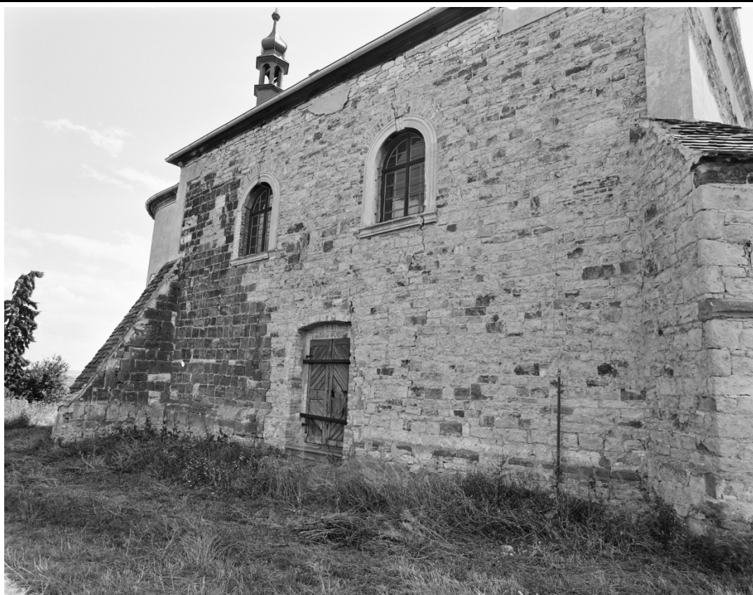
Severní průčelí lodi v pohledu od severozápadu. Foto: 2006, sbírka negativů NPÚ ÚOP v Ústí n. L., sign. 179530.
