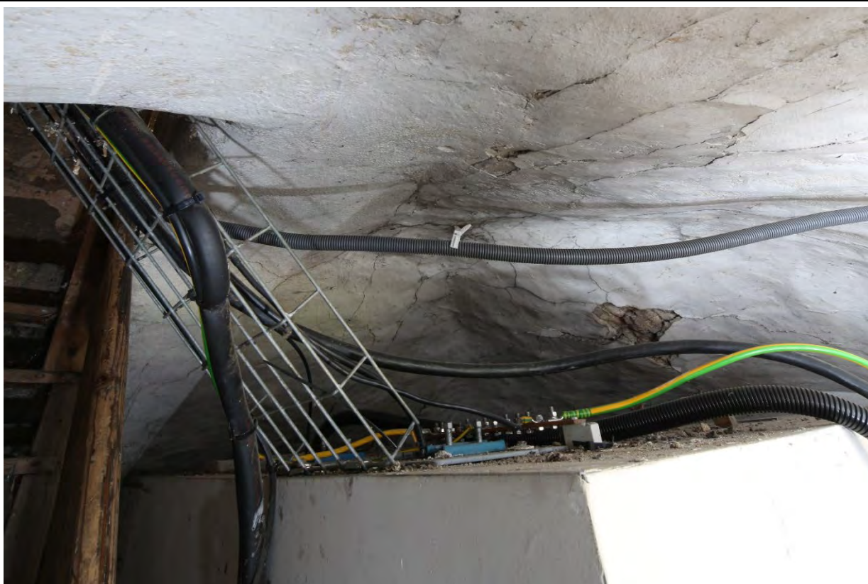
Vrcholnice klenby přízemí věže v pohledu od jihovýchodu. Foto: Marta Pavlíková, 2018.
