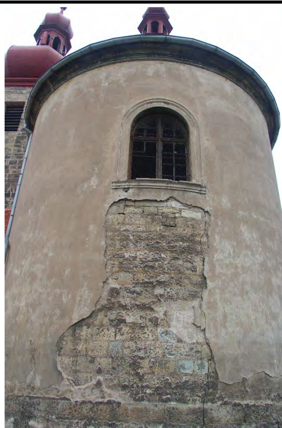
Východní průčelí presbytáře. Foto: Jan Koloc, 2004.
