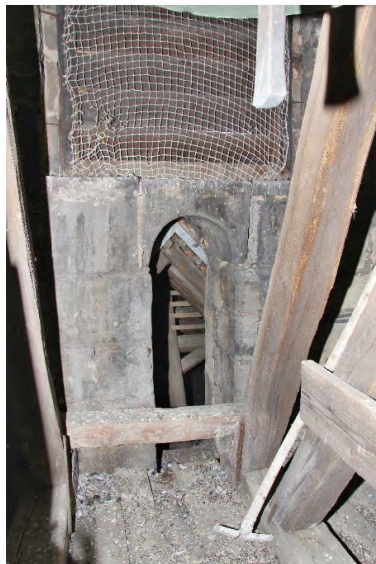
Severní strana třetího patra věže s prostupem do krovu nad lodí. Foto: Jaroslav Skopec, 2019.
